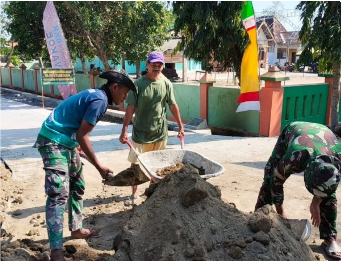
Satgas TMMD Reg 117 Kodim 0717/Grobogan Melaksanakan Finishing Jalan Dengan Pembereman
